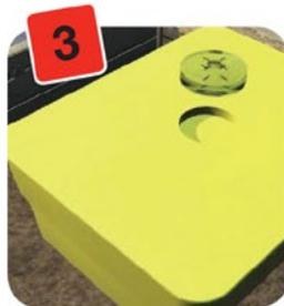
Se la livella a bolla circolare non è montata nel coperchio dell'AQUAbox Straight, inserirla semplicemente nel piccolo foro nel coperchio. Spingerla saldamente in modo tale da montarla correttamente in posizione.
